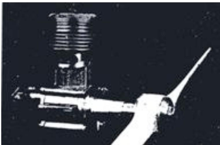
Ecco la fotografia del prototipo del motore Z-3 progettato dall'ing. V. Valle e prodotto in serie, con alcune modifiche, dall'artigiano Giovanni Bet. Il motore si presenta robusto, compatto e di costruzione accurata.
